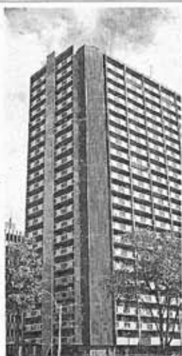
集合住宅に設置したコンサーバル社の集熱板(中央部分、カナダ・オンタリオ州)
