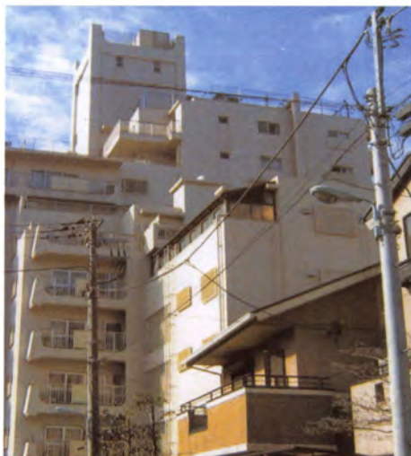
日商岩井目白台マンション (日商岩井)
